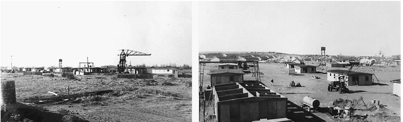
Figura 11 Montaje de viviendas con el sistema de Sofer en Plaza Huincul. Fuente: Sofer (1949).
